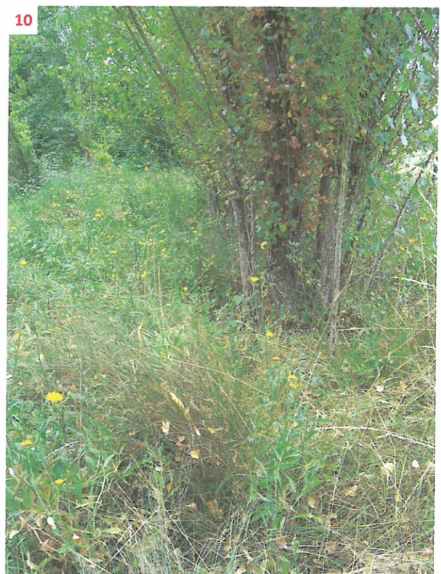
Fossé extrémité Est
